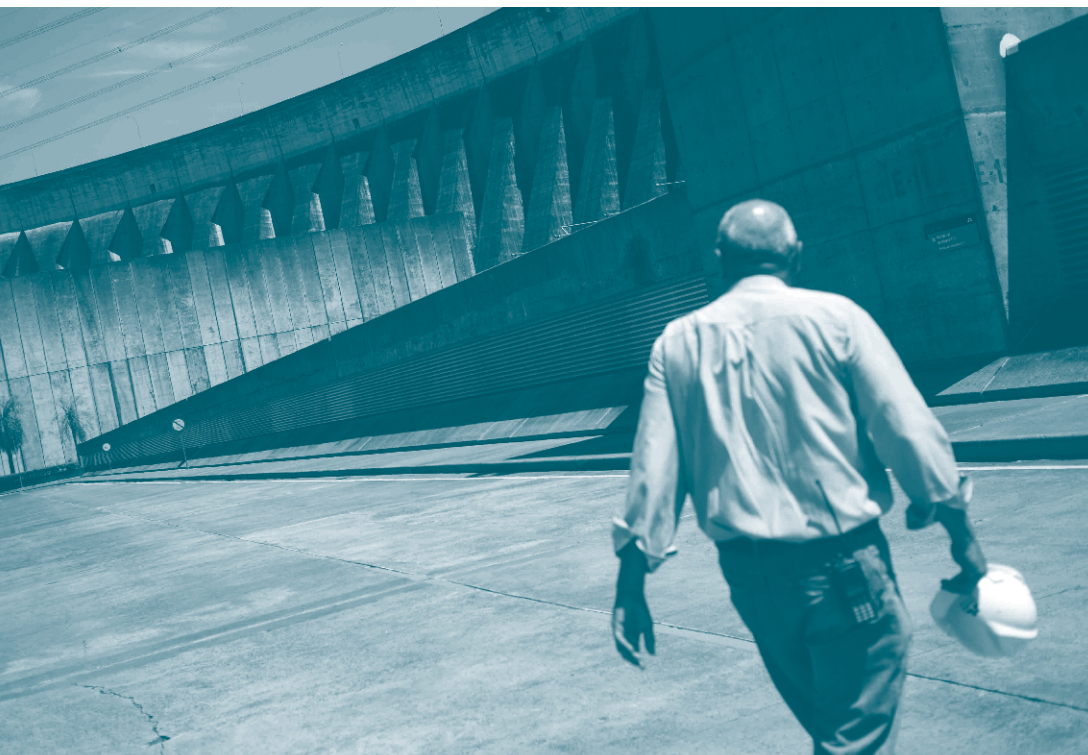
Represa de Itaipú que ilustra la CSS Bilateral entre Paraguay (oferente) y El Salvador (receptor) para la construcción y mantenimiento de proyectos hidroeléctricos. Autor: Santiago Carneri.
